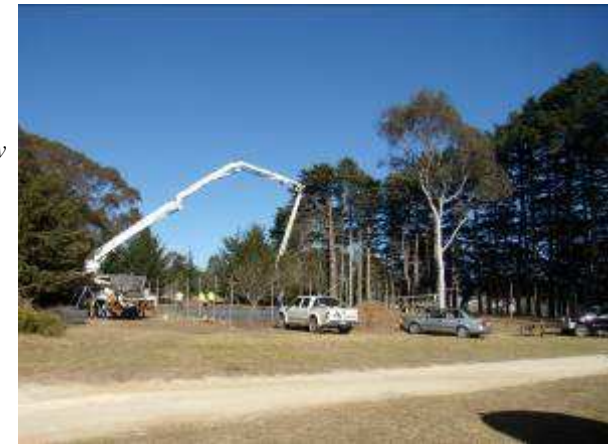
Pouring the new court
